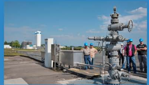
Vue du site pilote d'injection de Ketzin montrant le puits d'injection.
