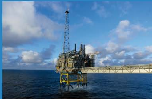
Photographie de la plate-forme Sleipner en mer du Nord.
